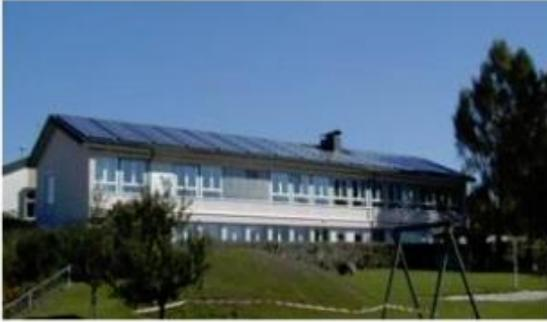
Seit dem Frühjahr 2003 sind die beiden Fotovoltaikanlagen - eine mit 242m<sup>2</sup> Kollektorfläche auf dem Dach der Volksschule Elixhausen und eine mit 204m<sup>2</sup> Kollektorfläche auf dem Dach der Feuerwehrzeugstätte - in Betrieb und wandeln Licht in elektrische Energie um. Insgesamt 342 Solarmodule mit einer Gesamtleistung von rund 57.075 Wattpeak produzieren so umwelt-freundlich Strom und reduzieren dadurch den Ausstoß des Treibhausgases CO<sub>2</sub>.
